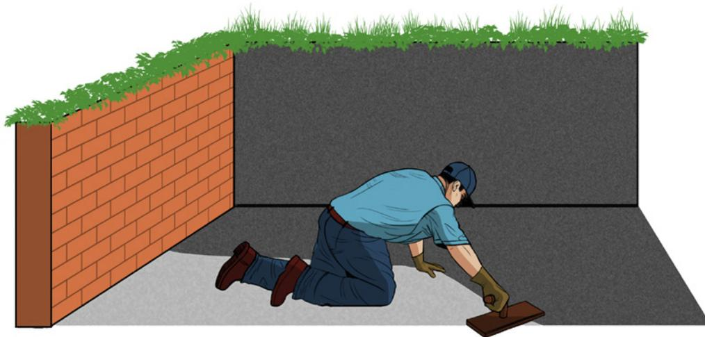
**Figura 31:** Impermeabilización del interior de la cámara con un revoque con hidrófugo.
